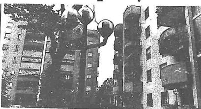
Casa di edilizia economica popolare a San Donato Milanese e Pignazzolo del Municipio (Foto Borsotti)
