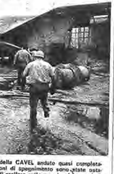
GORGONZOLA - Il moderno stabilimento della CAVEL andato quasi completamente distrutto nel rogo di ieri. Le operazioni di spegnimento sono state costolate dai muti partecianti che minacciavano di crollare sulle squadre dei pompieri.
