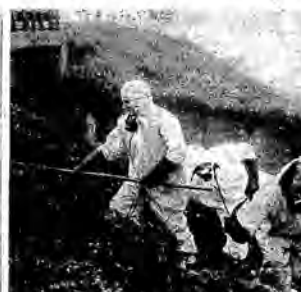
Uomini impegnati nelle operazioni di bonifica a Seveso.
