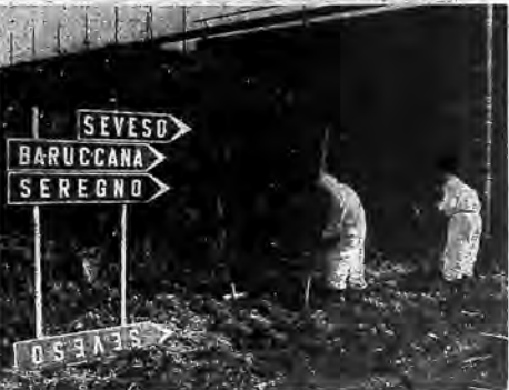
Si stanno completando i lavori di recinzione della zona A dopo le recenti decisioni della Regione che ha adottato la linea «dura» per gli interventi.
