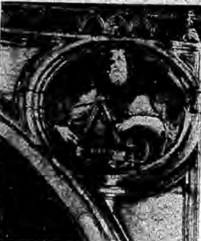
Un particolare della facciata del Duomo, evidenti i danni dell'incuria e dello smog sul busto di Agilnofo.
