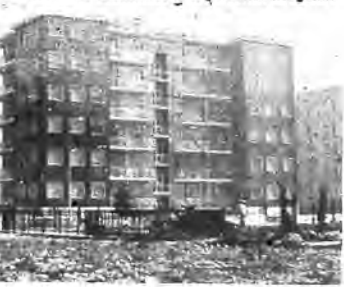
CASSINA DE' PECCHI - Uno degli edifici al centro dello scandalo edilizio.
